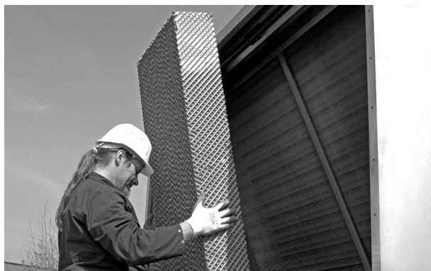
Снятие предохладительного материала
