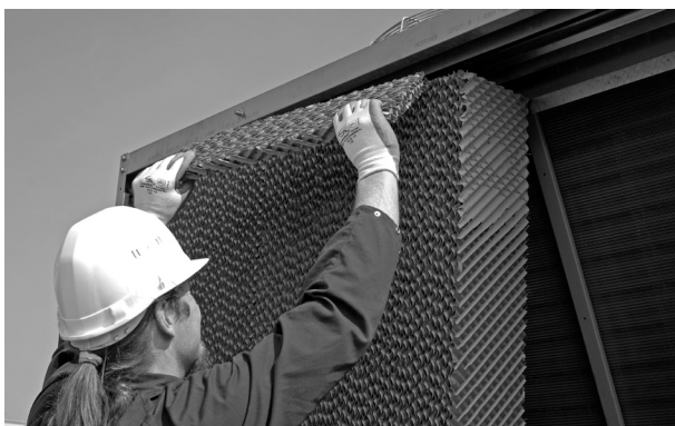
Извлечение водораспределительных панелей
