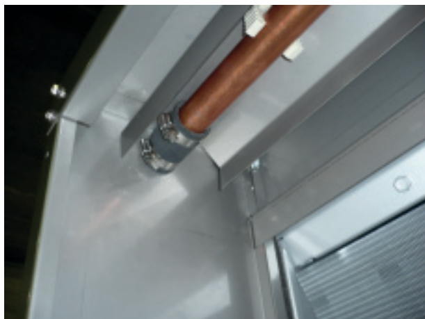
Соединение гибкого рукава с хомутами
