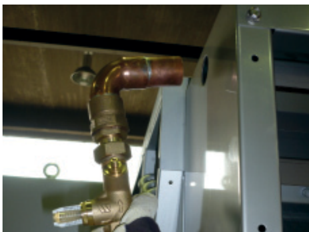
Подсоединение подачи воды
