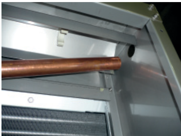
Установка медной трубы подачи воды
