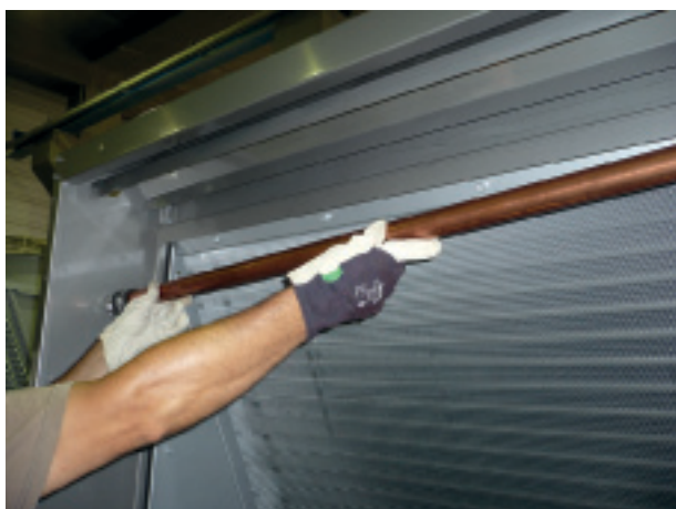
Извлечение медной трубы подачи воды
