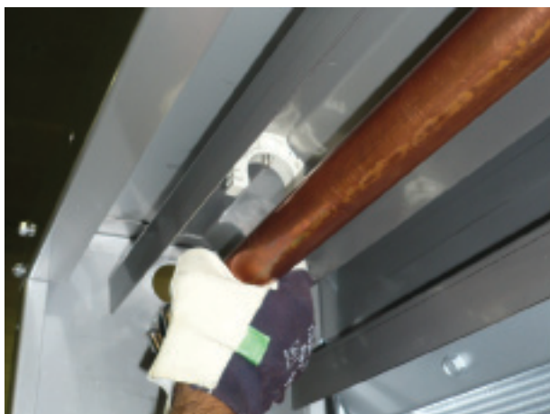
Высвобождение медного коллектора из пластиковых держателей
