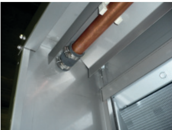
Соединение гибкого рукава
