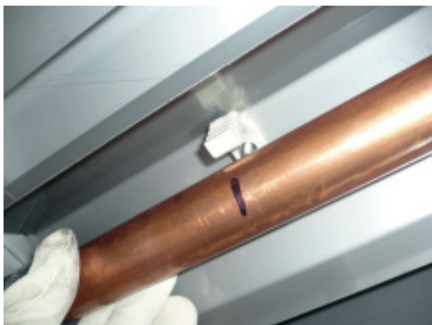
Совмещение трубы подачи воды
