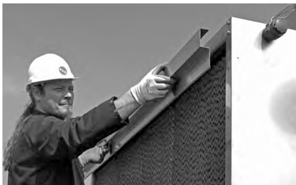
Снятие верхней пластины
