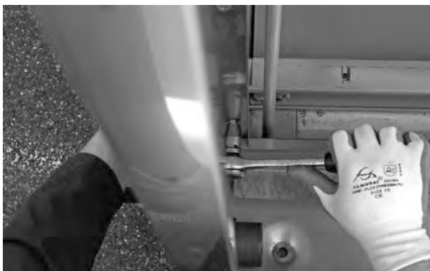
Монтаж рамы предохладителя на сухое изделие с помощью монтажных приспособлений из нержавеющей стали.
