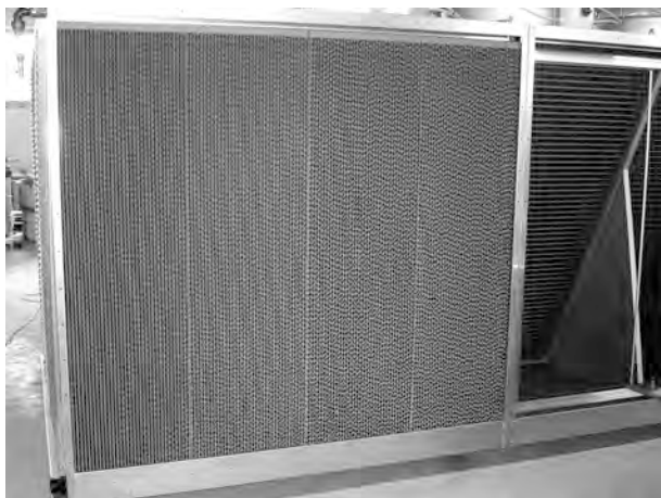
Продолжите установку предохладительного материала
