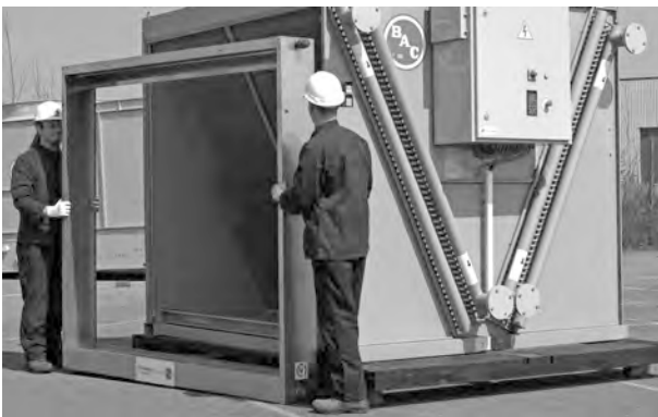
Монтаж пустой рамы предохлаждения на сухое изделие.
