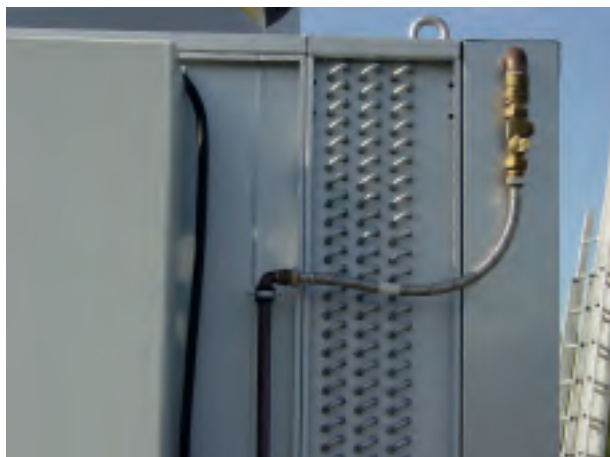
Соединение водоприемника предохладителя с уже установленным медным трубопроводом водораспределителя.
