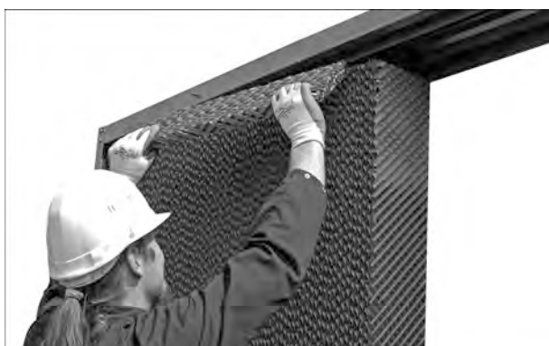
Извлечение зеленых водораспределительных прокладок
