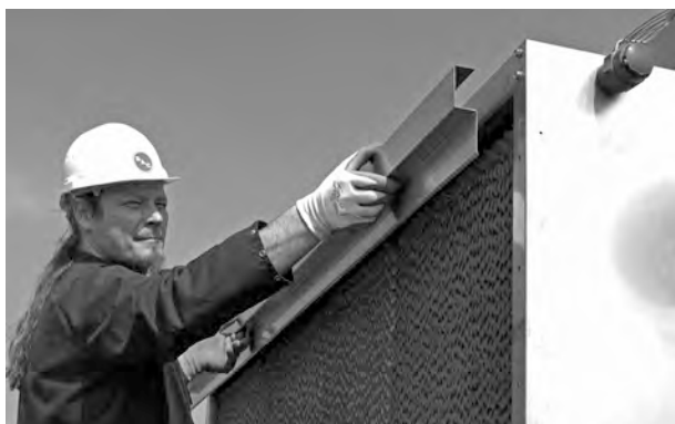
Установка на место верхней пластины
