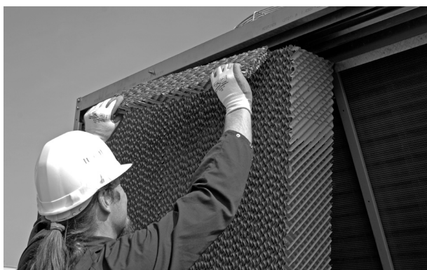
Извлечение водораспределительных панелей
