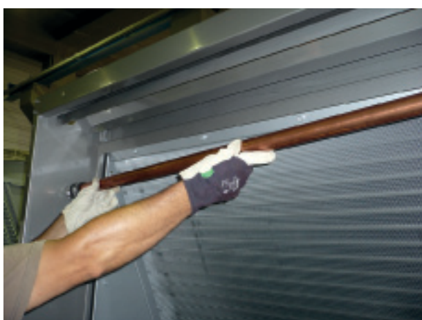
Извлечение медной трубы подачи воды
