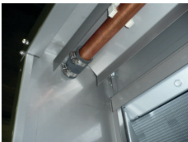
Соединение гибкого рукава с хомутами
