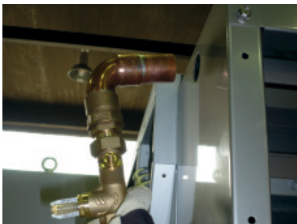
Узел подачи воды
