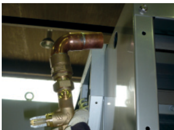
Подсоединение подачи воды
