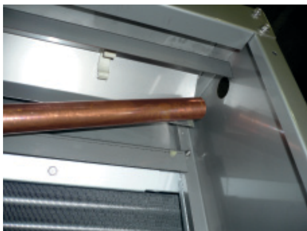
Установка медной трубы подачи воды
