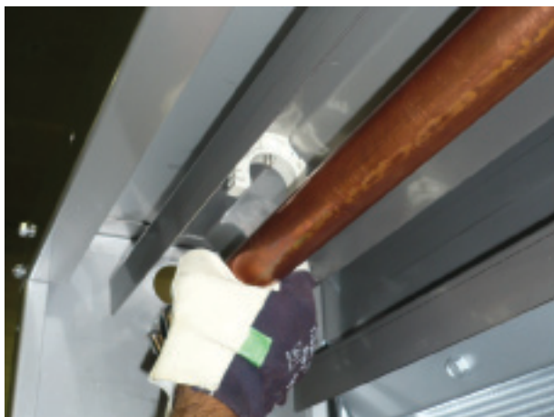
Высвобождение медного коллектора из пластиковых держателей
