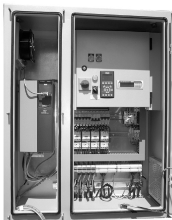
Панель управления с частотно-регулируемым приводом
