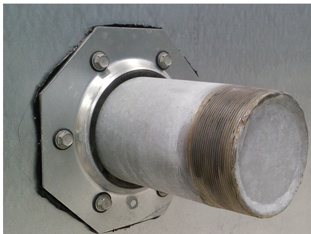
Соединение низкого перекрытого теплообменника (в градирнях закрытого типа с соединениями до ND100).
