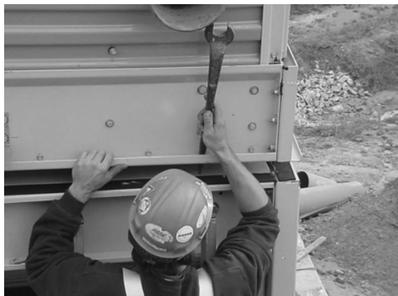
Соединение углов с помощью штифтов
