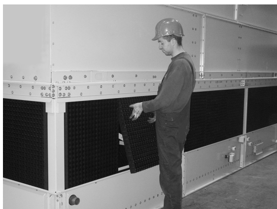
Снятие комбинированных экранов на входе
