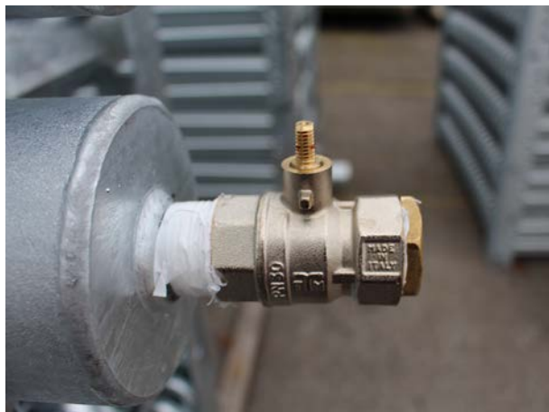
Соединение верхнего теплообменника с клапаном, стравливающим давление, на градирнях закрытого типа с соединениями больше, чем ND100.
