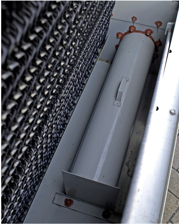
Бассейн холодной воды и сетчатый фильтр бассейна
