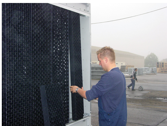
Снятие комбинированных экранов на входе
