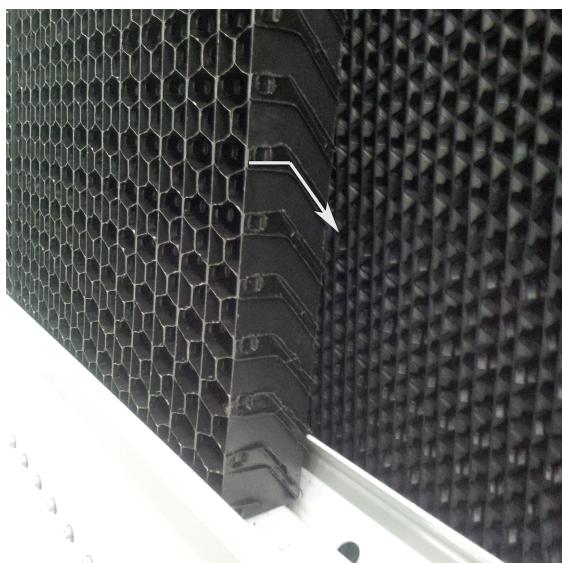
Ориентация комбинированных экранов на входе
