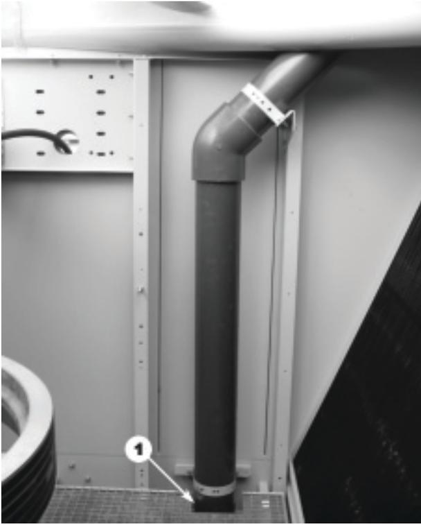
*Трубопровод насоса в секции вентиляционной камеры, вид изнутри*
