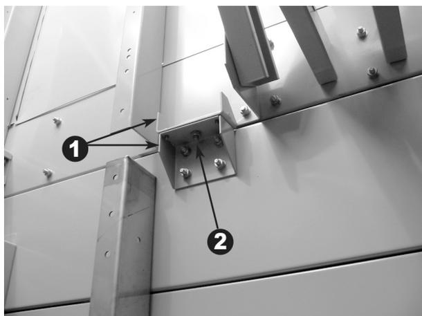
*Секция вентиляционной камеры, смонтированная на нижней секции*
