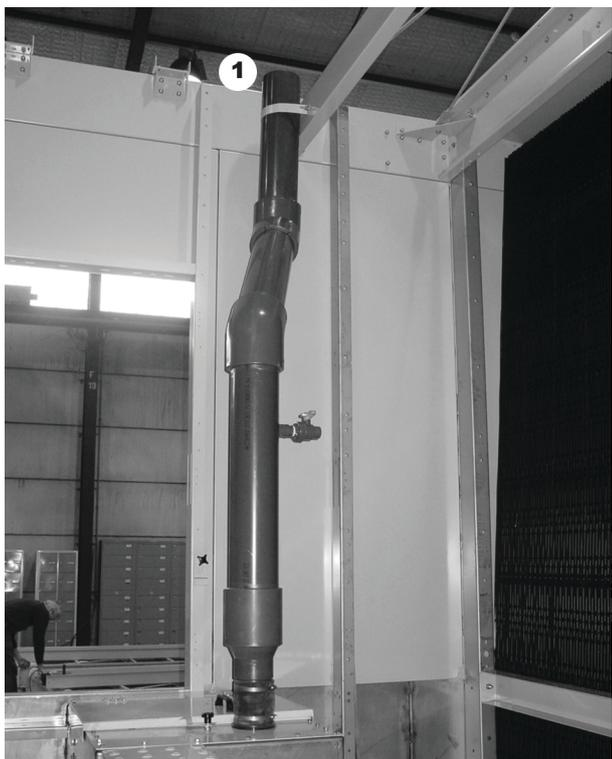
*Трубопровод насоса в нижней секции*
