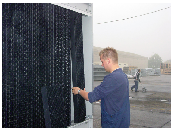
Снятие комбинированных экранов на входе
