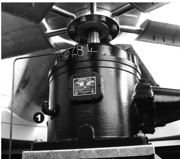
Зубчатая передача с одним редуктором
