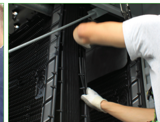
Запатентованный наполнитель VACross для простоты осмотра и очистки
