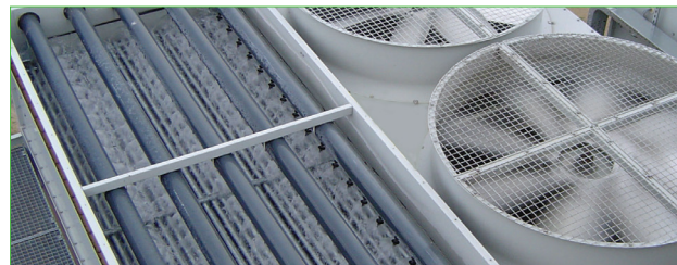
Полный доступ к системе оросительного распределения и верхушке теплообменника в процессе работы
