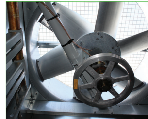
Легкодоступная система привода вентилятора с удлиненными смазочными линиями*
