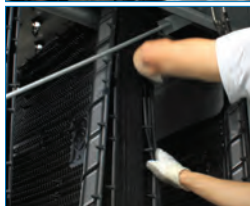
Запатентованный наполнитель VACross, обеспечивающий легкий осмотр и очистку лист за листом
