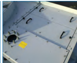
Крышки распределительного бассейна*
