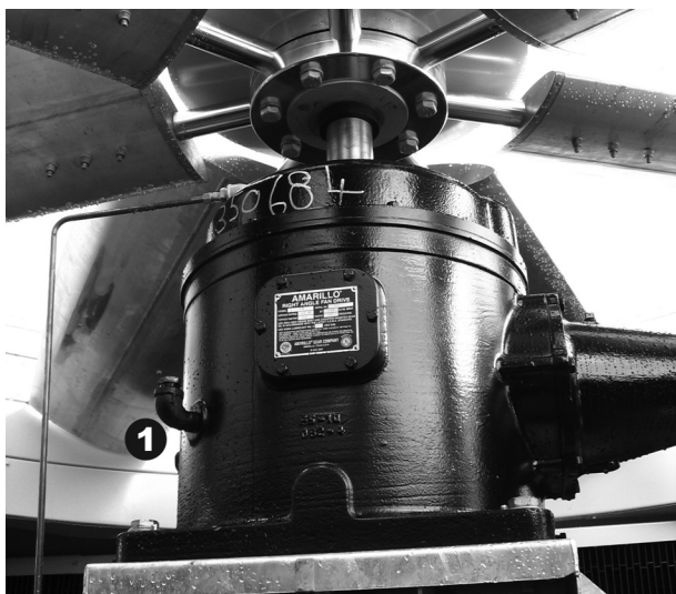
Зубчатая передача с одним редуктором
