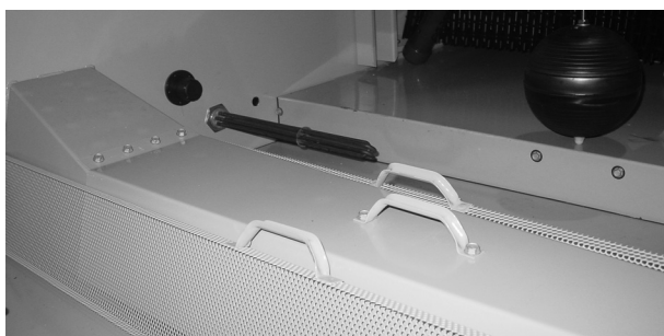
Бассейн холодной воды и сетчатый фильтр бассейна
