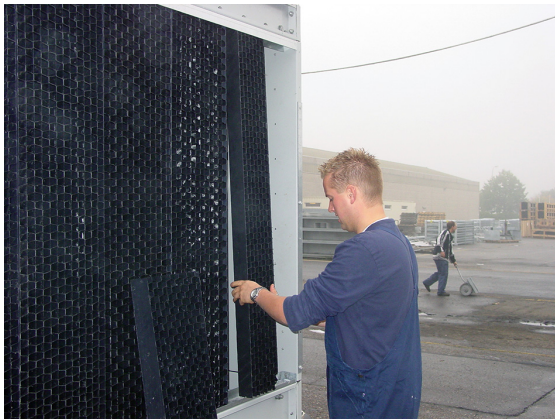
Снятие комбинированных экранов на входе
