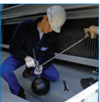
обслуживание на объекте
