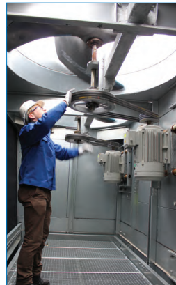
Система привода вентилятора легко доступна при стоянии
