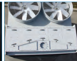
Крышки распределительного бассейна*
