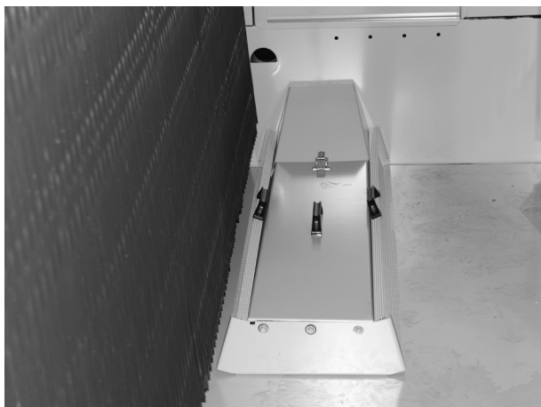
Бассейн холодной воды и сетчатый фильтр бассейна
